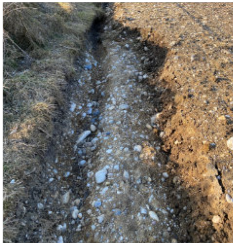
Flurschaden nach einem Starkregen.
