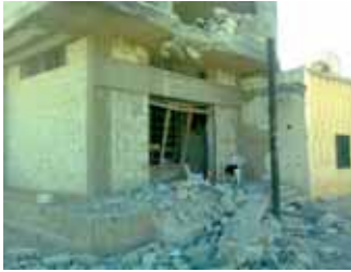
zerstörtes Haus vom Bruder
